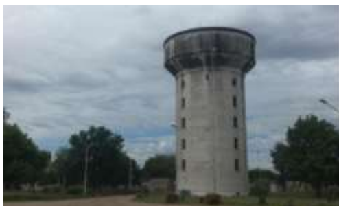
Figura XI. Tanque de almacenamiento de agua de San Justo.
